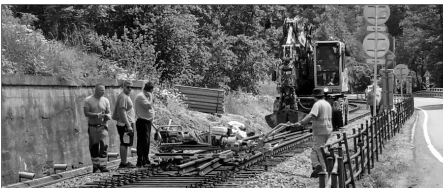
V rámci pravidelných letních výluk na železnici, kdy se sekáním obnovují rozhledové poměry, čistí a opravují železniční přejezdy, došlo tentokrát i na čištění štěrkového kolejového lože a opravu železničního svršku na těch nejnámáhanějších úsecích. Foto Petr Mahel
