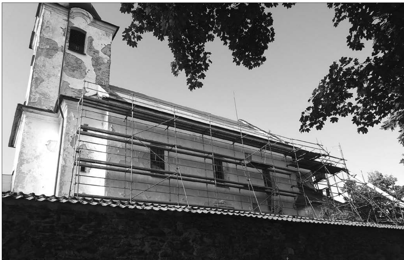
Letos v létě probíhala oprava střechy kostela ve Vojtíškově.
