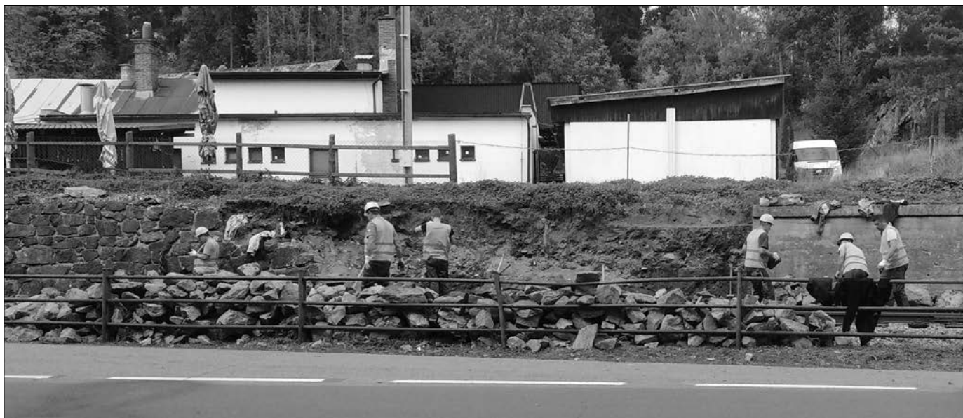
V říjnu byla konečně zahájena oprava zborcené zídky vedle železniční tratě pod naším pohostinstvím.
