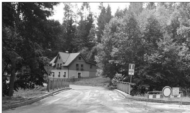
Letos v létě se opravovala silnice na Vysoký Potok.
