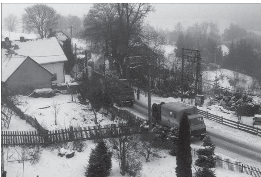
V prosinci byla ve Vojtíškově provedena rozsáhlá výměna sloupů a elektrického vedení.
