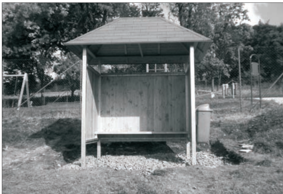
Na točně autobusu ve Vojtiškově nahradila dožívající plechovou boudu nová autobusová zastávka.
