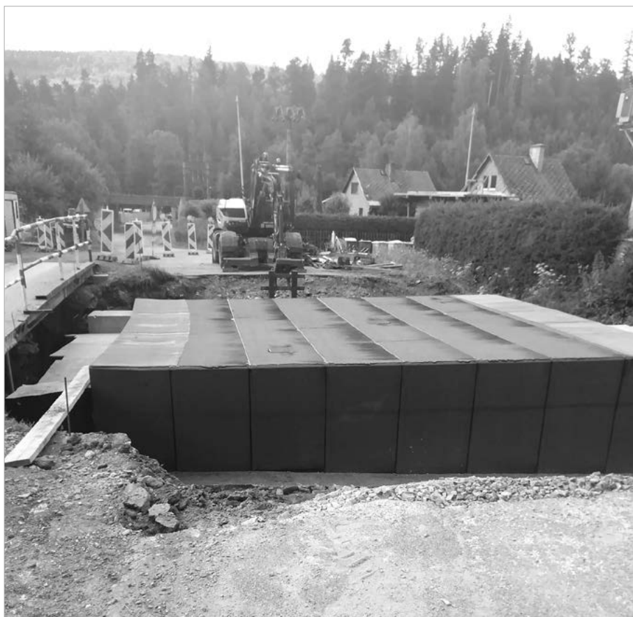
Kousek nad pilou, na silnici směr Podlesí, probíhá plánovaná oprava mostku.
