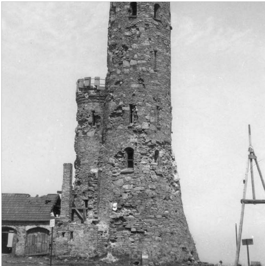
Jeden z posledních snímků detailů zdíva staré sněžnické rozhledny, svědčící o jejím katastrofálním stavu. Její odstřel provedla téměř tajně polská armáda.
